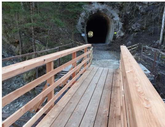
Die neue Rickenbach-Brücke aus Lärchenholz
